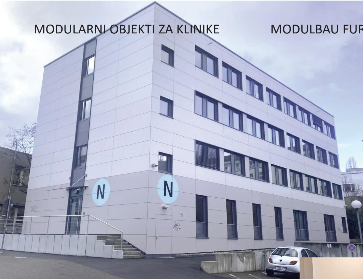
Modularni objekt na 4 etaže za Katharinenhospital, Stuttgart. Sastoji se od 35 modularnih jedinica dim. 12,22x2,98x3,50 m.
