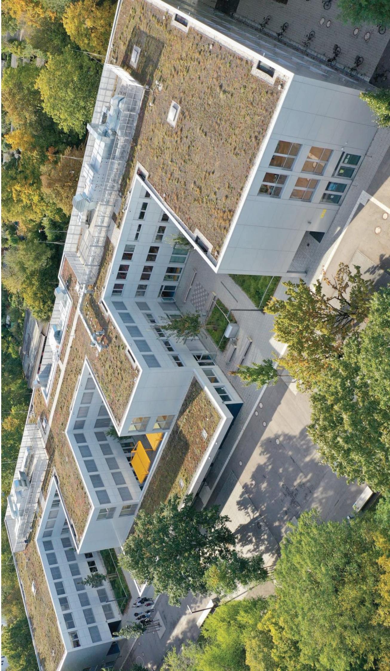
Školski kompleks, 357 modularnih jedinica dimenzija  $10.190 \times 2.991 \times 3.575$  mm i  $7.560 \times 2.991 \times 3.575$  mm. Tlocrtna površina objekta  $9.360,00 \text{ m}^2$ . Die Schulanlage, 357 Stk. Moduleinheiten Abm.  $10.190 \times 2.991 \times 3.575$  mm und  $7.560 \times 2.991 \times 3.575$  mm. Die Grundfläche beträgt  $9.360,00 \text{ m}^2$ .
